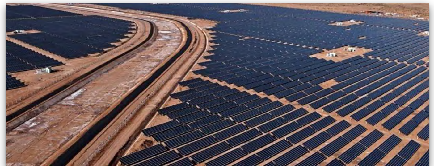
Centrale photovoltaïque au sol de Kamuthi, Inde
